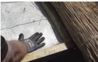
Brandsikring udføres før tækning
