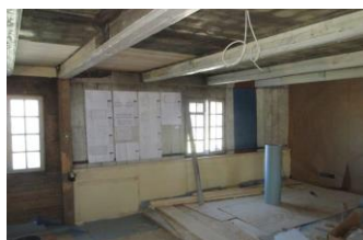
Efterisolering med træfibermåtter
