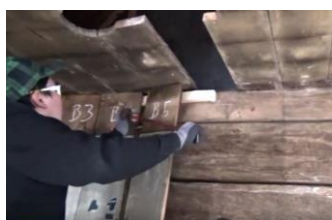
Nedtagning før genmontering
